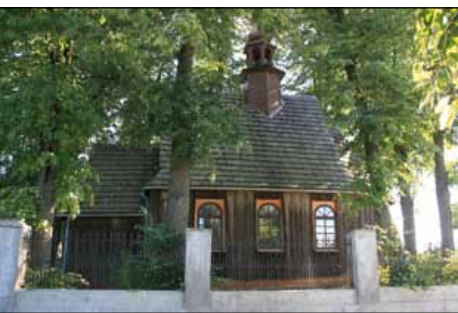
Kaplica w Dąbrowie
